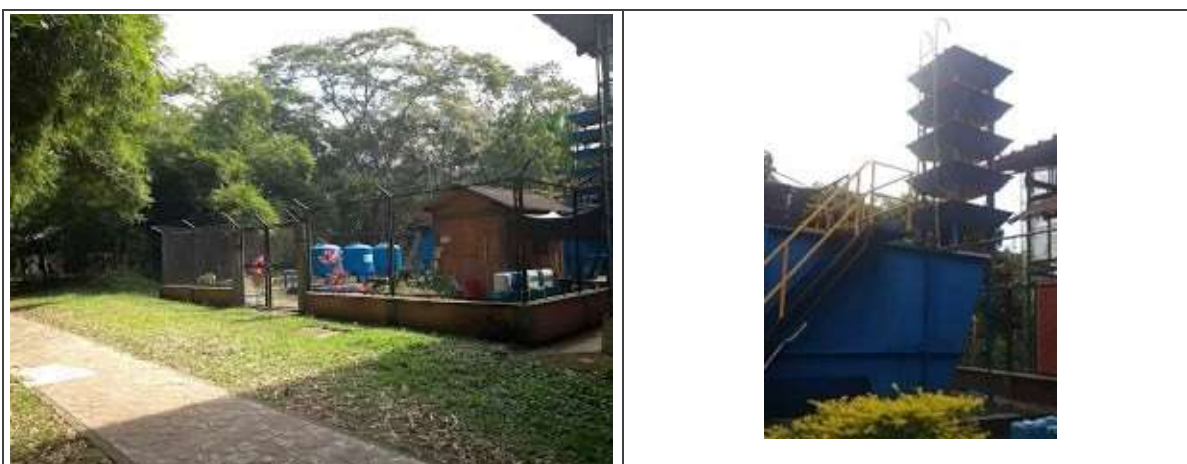
Fotos 15 y 16: Vista general de la Planta de Tratamiento de Agua Potable y de la torre de aireación.
