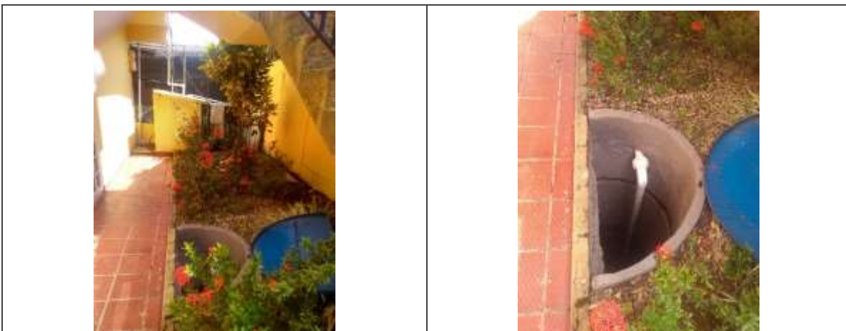
Fotos 3 y 4: Aljibe Granja, con su sistema de captación y derivación.
