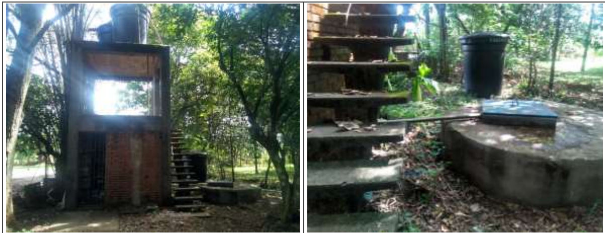
Fotos 9 y 10: Aljibe INAT, con su sistema de captación y derivación.
