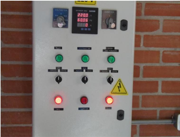
4. Verifique que las tres fases de corriente que alimentan el tablero eléctrico estén energizadas, mediante el selector VOLTIMETER, girando hacia la izquierda este selector de OFF a RS, ST y TR, todas tres deben mostrar en el Voltímetro Análogo 220 – 230 voltios.
