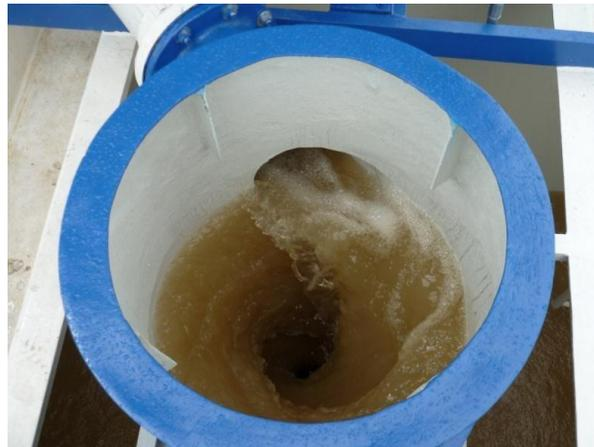
La Coagulación es la segunda operación unitaria de potabilización y consiste en mezclar los productos químicos necesarios para la potabilización con el agua cruda del pozo, esta etapa se lleva a cabo en el equipo de mezcla rápida, tipo HIDROCICLON, cuya operación es completamente a gravedad (no se requiere energía eléctrica para lograr la mezcla).
