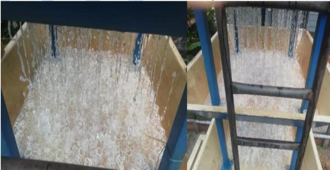
Bandejas de aireación con Pall ring's
