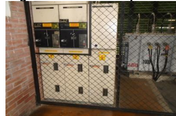
Imagen 4 Celda de Acople GAM-1
