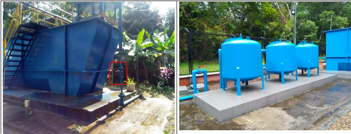
**Fotos 17 y 18:** PTAP: tanque principal de procesos, macromedidor (demarcado) y filtros.
